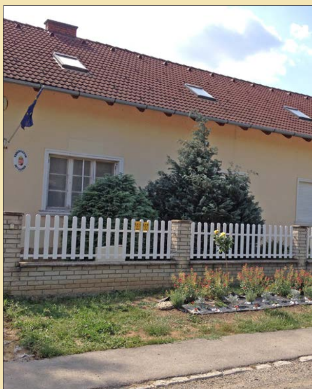
Az óvoda kerítése a festés után
